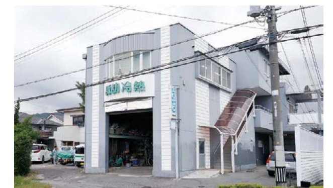
有限会社 諏訪冷熱 長野県諏訪郡下諏訪町赤砂 4359-11
