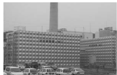
冷水蓄熱水槽
