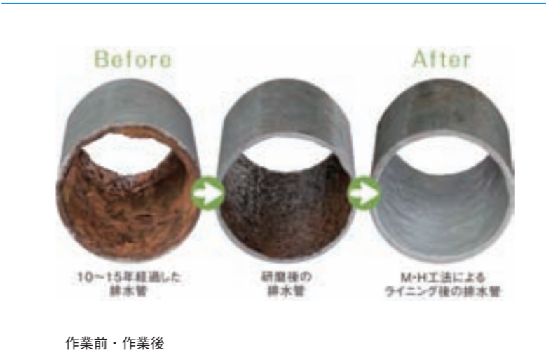
作業前・作業後
