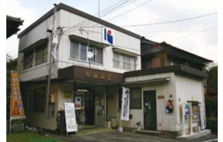
▲左神田組の本社社屋。地域の各種公共工事を通じて地元・川根本町に貢献しています
