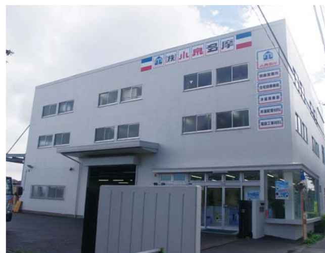
新奥多摩街道沿いの便利な立地。多摩大橋通りに近いので、八王子や武蔵村山へも出やすい場所にある。
